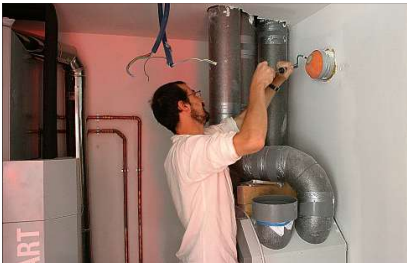
Trois tests d'étanchéité ont été réalisés sur ce chantier, avant, pendant et après les travaux. Dans les rénovations performantes l'étanchéité à l'air est un élément-clé. Photo DR
